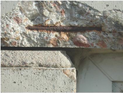
Abbildung 1: Typischer Carbonatisierungsschaden
