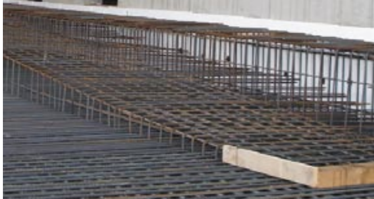
Bild 4. Bewehrung einer Rampe
